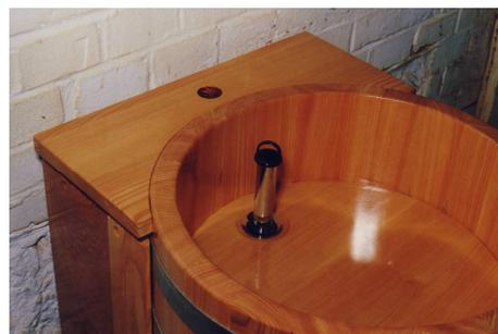
L'écoulement est raccordé par raccord 1 ¼ "
